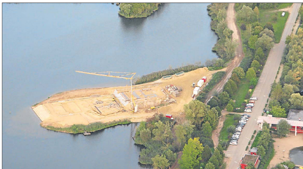
Auf der neuen Halbinsel laufen die Arbeiten auf Hochtouren.
