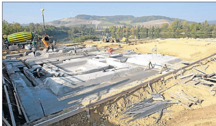
Auf dem Fundament entsteht ein Gebäude aus Holz.
